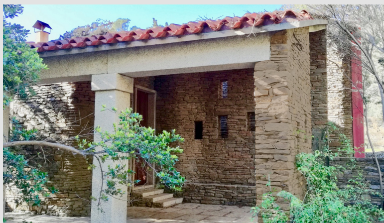
Fig. 8 – Sinnai, casa unifamiliare degli anni '70, con murature in scisto di Gadoni e pilastri del loggiato in granito di Buddusò (progetto P. Mistretta)
