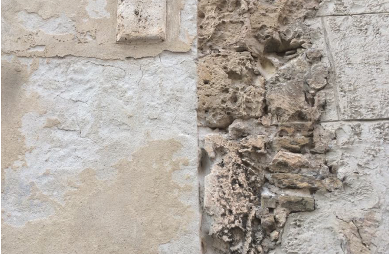
Fig. 4 – Trattamento superficiale in intonaco di calce a protezione della struttura muraria (ph: Ginevra Balletto)
