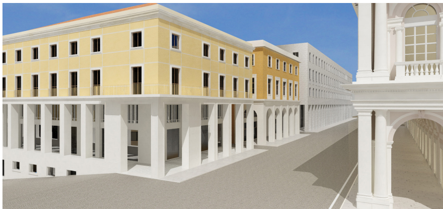
Fig. 27: Ricostruzione virtuale dei Quattro Cantoni secondo il progetto di ristrutturazione urbanistico-edilizia, non realizzato, di Cortelli e Bucci: il Palazzo dell'INA, il Banco di Napoli (più corto dell'attuale perché costituito dalla sola prima unità) e l'edificio porticato mai costruito.
