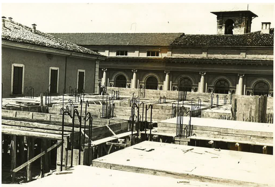
Fig. 25: Il cantiere del Palazzo dell'INA: foto storica della realizzazione dell'edificio.
