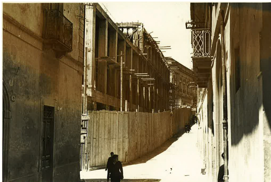
Fig. 26: La costruzione del Palazzo dell'INA.
