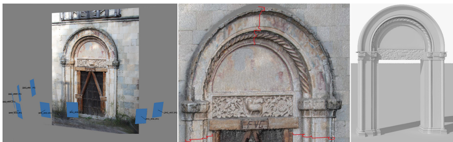
Fig. 6 Workflow per la modellazione del portale di S. Maria del Guasto (L'Aquila):rilievo fotogrammetrico; individuazione della geometria del portale dalla nuvola di punti; modello tridimensionale continuo.
