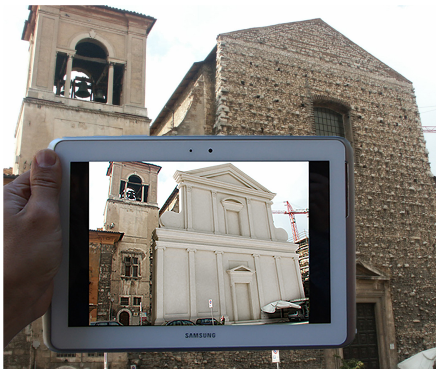
Fig. 11. Applicazione di Realtà Aumentata: visualizzazione della facciata non completata della chiesa di Santa Margherita (L'Aquila), in sovrapposizione allo stato attuale.
