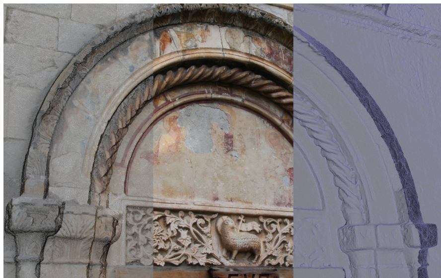
Fig. 5 Nuvola di punti e mesh, con e senza texture: fotomodellazione del portale della chiesa di Santa Maria del Guasto (L'Aquila sec. XV), la cui facciata, nel 1935, viene smontata e rimontata per la chiesa di Santa Maria degli Angeli, fuori porta Napoli.
