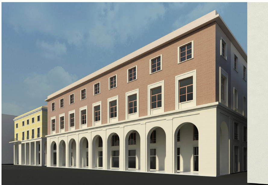
Fig. 13. Vista del Banco di Napoli, con i portici in continuità con quelli del palazzo dell'INA.
