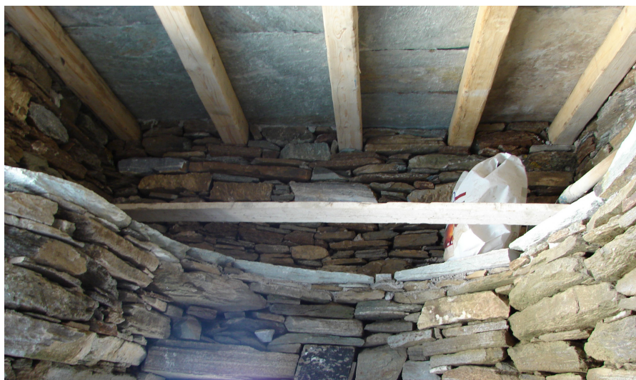
Figura 3.24 - Interni. In alto, ambiente coperto dal sistema originario a corbelling. A sinistra si nota una mangiatoia ricavata nell'angolo. In basso, modifica apportata alla copertura del vano adiacente: le lastre di chiusura della falsa cupola sono state rimosse e il volume è stato sopraelevato di circa 60 cm, prevedendo una nuova orditura di travi lignee con sovrastanti lastre di scisto.
