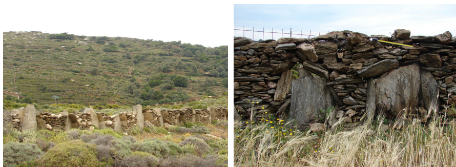
Figura 12 - Phraktes ad Andros. A sinistra veduta di insieme di un muro di recinzione; a destra dettaglio della tessitura di pietre grezze intervallate da lastre di scisto.
