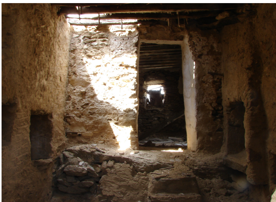
Figura 3.10 - Nella pagina a fianco, in alto, particolare della facciata laterale che si affianca alla roccia affiorante per risparmiare materiale per la costruzione; in basso, interno della casa ripreso dal vano inferiore.
