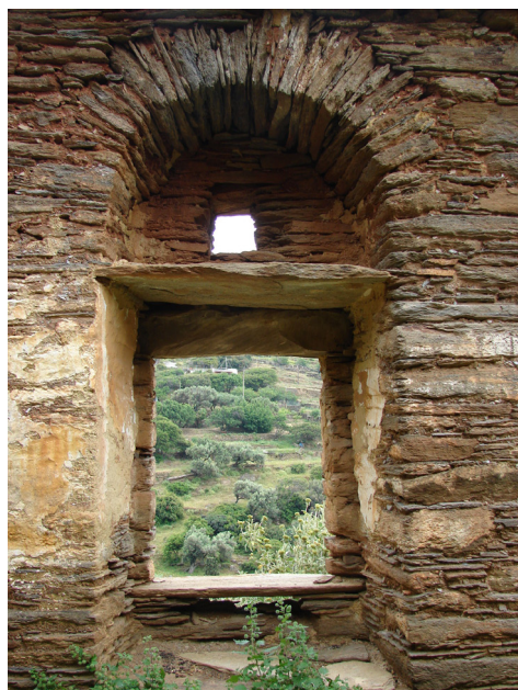
Figura 19 - Andros, nicchie per la conservazione delle vivande (parathires). A destra, il piccolo sopraluce, oltre a essere un'ulteriore sorgente di aria e luce, diventa utile elemento di areazione per i cibi e le vettovaglie che si conservavano sulla mensola.
