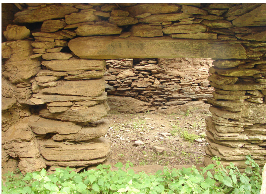
Figura 3.22 - Interno di una delle due stalle, illuminato da un'unica piccole bucatura. In basso, dettaglio della porta di ingresso di uno degli ambienti.
