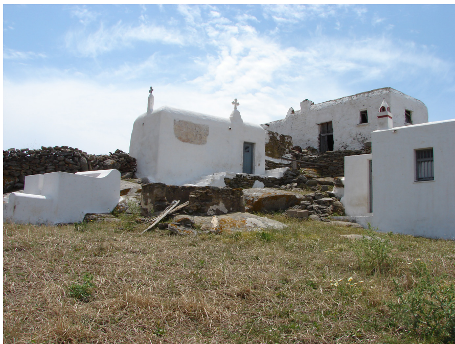
Figura 3.9 - Veduta generale del Chorio, con l'edificio principale, gli annessi e la cappella.
