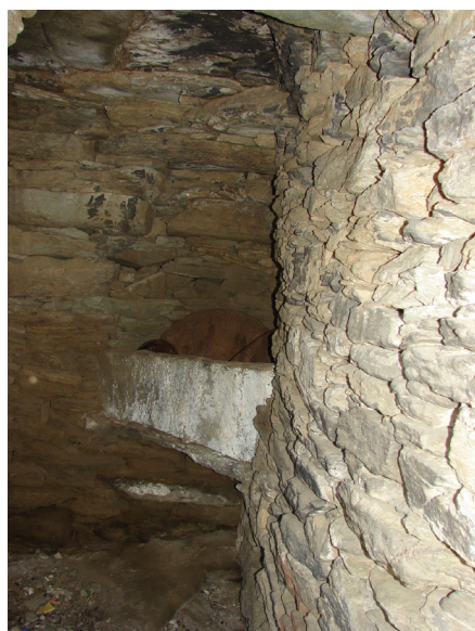
Figura 3.26 - In alto, ingressi ai due vani della stalla. Si notano le lastre che aggettano sopra la bucatura a protezione sia dal sole che dalle acque meteoriche.
