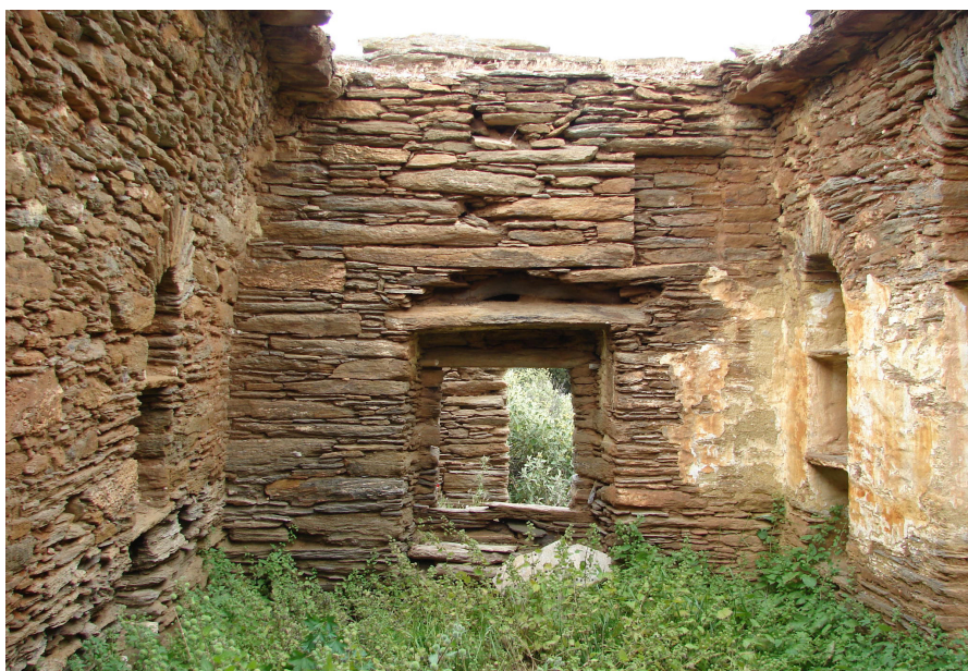
Figura 3.16 - In alto, fronte sulla valle. Le finestre sono dotate di lastre aggettanti che sopra la bucatura allontanano le acque piovane, mentre sul bordo inferiore formano il davanzale. In basso, veduta interna della katoikia. Lungo le pareti sono presenti nicchie per la conservazione del cibo (thyrides) ricavate nello spessore dei muri con la massima cura negli ammassamenti degli stipiti e degli archi di chiusura.
