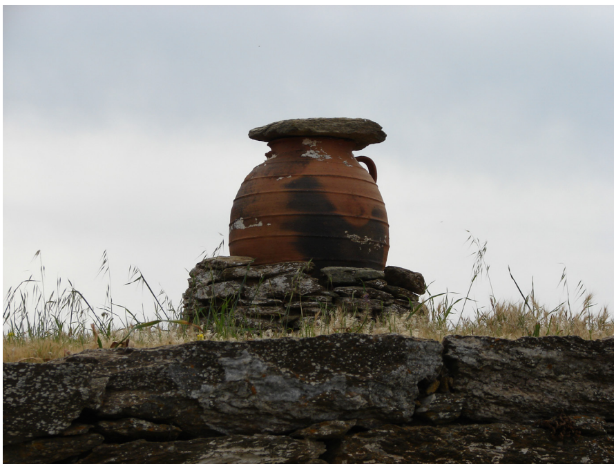
Figura 31 - Kapasos, comignolo largamente utilizzato nelle quattro isole costituito da un'anfora di terracotta privata della base, poggiata sulla parte terminale della canna fumaria.
