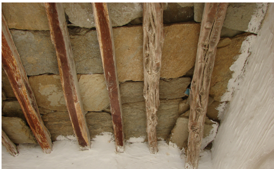
Figura 27 - Intradossi delle varie tipologie di copertura. Dall'alto: soluzione angolare con lastra di scisto triangolare (Tinos); orditura lignea con sovrastante incannucciato lineare o intrecciato (Mykonos) ; orditura lignea con campate coperte da lastre di scisto (Andros).
