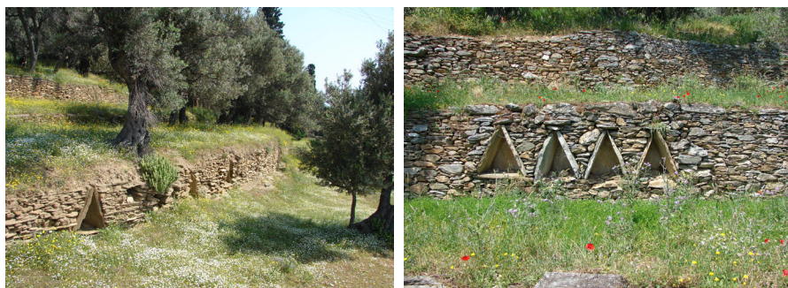
Figura 13 - Muri di contenimento di una proprietà ad Andros. I fori di drenaggio diventano veri e propri elementi ornamentali del paramento.
