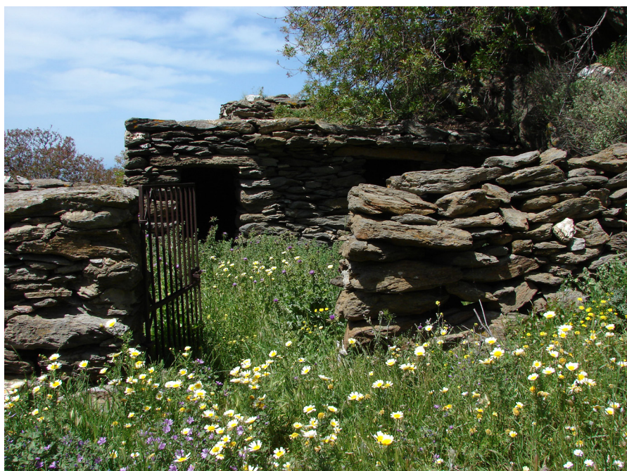
Figura 3.7 - Vedute generali della corte e della stalla.
