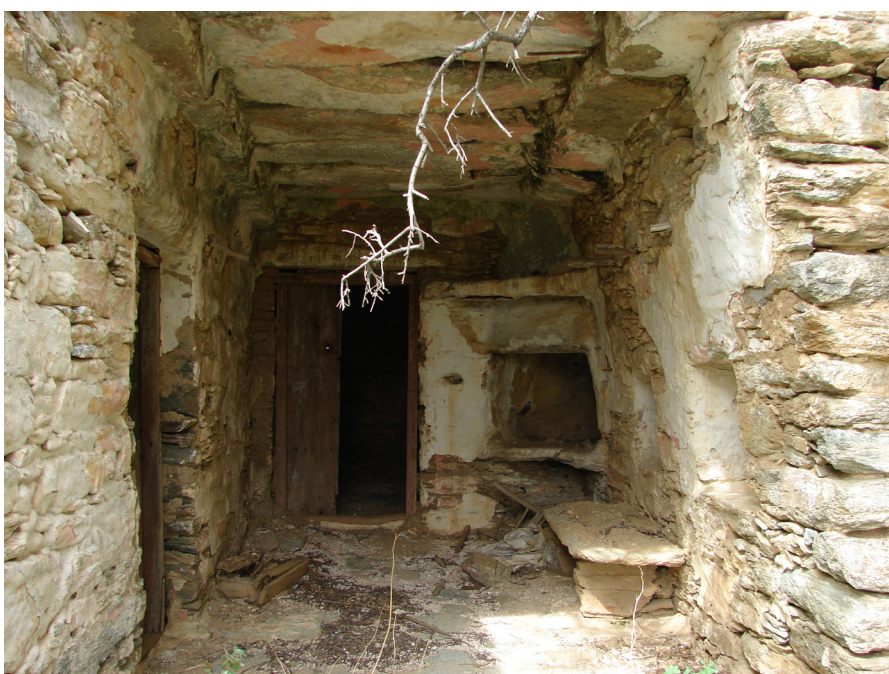
Figura 3.2 - In alto, vista dello stegadi dalla corte (avli); sulla parete di sinistra si nota una delle lastre aggettanti, predisposte per risalire agevolmente la parete e raggiungere il tetto nelle fasi di manutenzione. In basso, vista di dettaglio dello stegadi; si nota come la parete di destra sia sagomata a mensola, mentre la parete a sinistra sia retta e le lastre di copertura poggino su mensole aggettanti.
