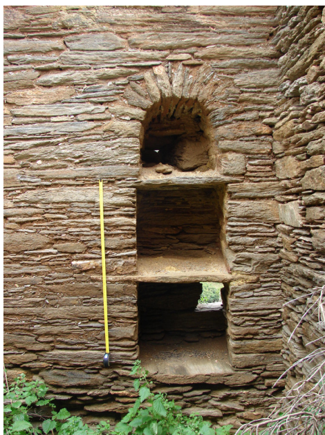
Figura 19 - Andros, nicchie per la conservazione delle vivande (parathires). A destra, il piccolo sopraluce, oltre a essere un'ulteriore sorgente di aria e luce, diventa utile elemento di areazione per i cibi e le vettovaglie che si conservavano sulla mensola.
