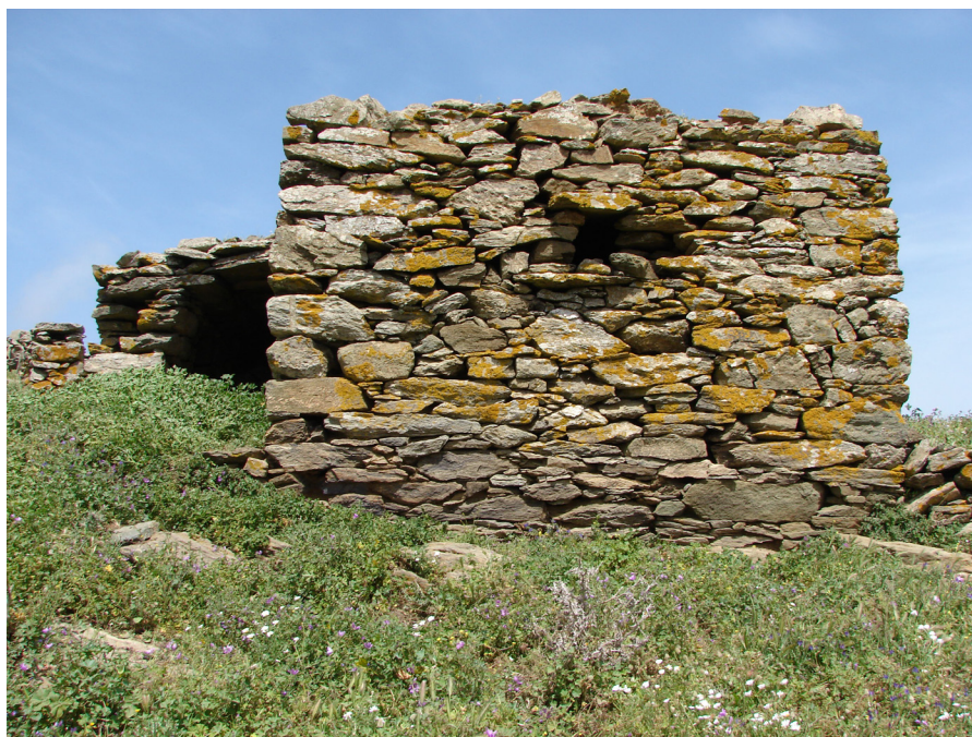
Figura 3.5 - Vista laterale del rifugio (in alto) e vista frontale (in basso).
