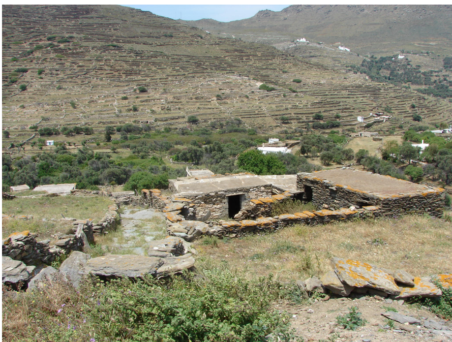
Figura 22 - Esempi di stalle. In alto, Kea, stalla realizzata a ridosso della parete rocciosa; all'ingresso si osserva una porzione di roccia affiorante intagliata per diventare un abbeveratoio. In basso, Tinos, sistema di stalle lungo i terrazzamenti solcati da un percorso lastricato.
