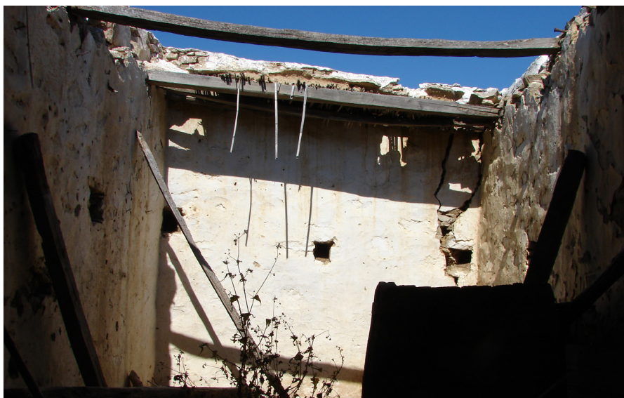
Figura 3.12 - In alto, veduta della facciata posteriore del chorio, dalla quale emerge il volume del forno con la cupola estradossata. In basso, veduta dell'interno verso il fronte nord, dove si osservano dei fori di alloggiamento di travi che dovevano formare un soppalco ligneo.
