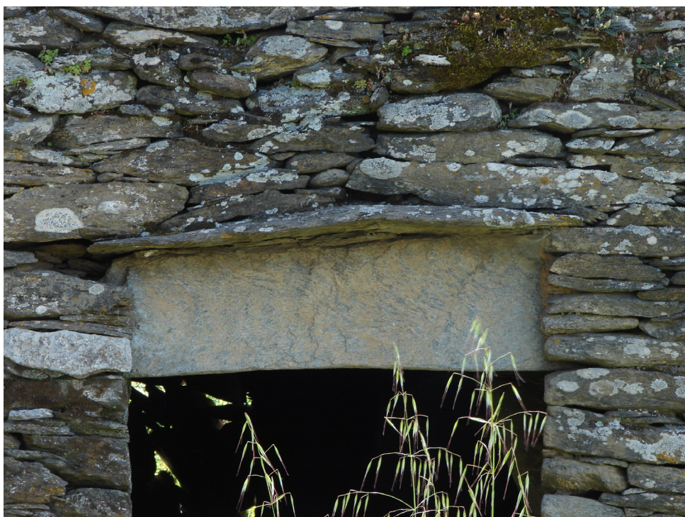
Figura 29 - Riprese di dettaglio di alcune soluzioni di chiusura delle bucatore (con arco di scarico o con architravi formate da lastre di scisto disposte di piatto e di taglio).
