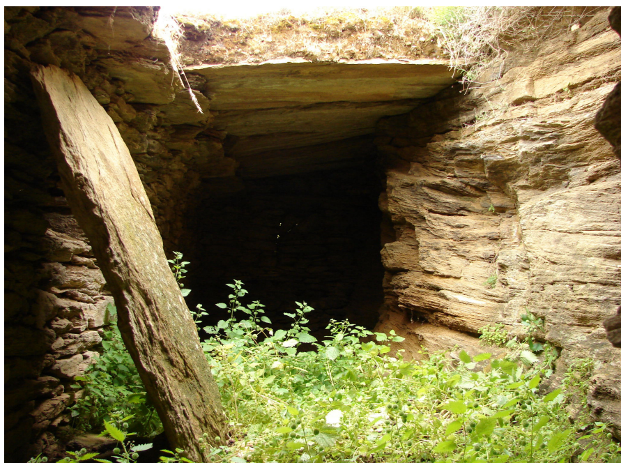
Figura 3.21 - In alto, veduta generale delle stalle. Si nota anche qui, come nelle case, la presenza di mensole aggettanti dal muro utili a raggiungere il tetto a tumulo nella fase di manutenzione. In basso, interno della stalla. Il volume si addossa alla parete rocciosa e vi appoggia la struttura a falsa cupola della copertura.
