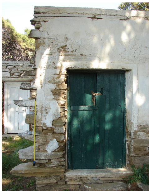
Figura 3.17 - In alto, veduta del fronte principale sulla corte. In copertura, si nota la grande canna fumaria conica dello tzaki (v. pagina seguente). In basso, morse di attesa sulla parete della kouzina.
