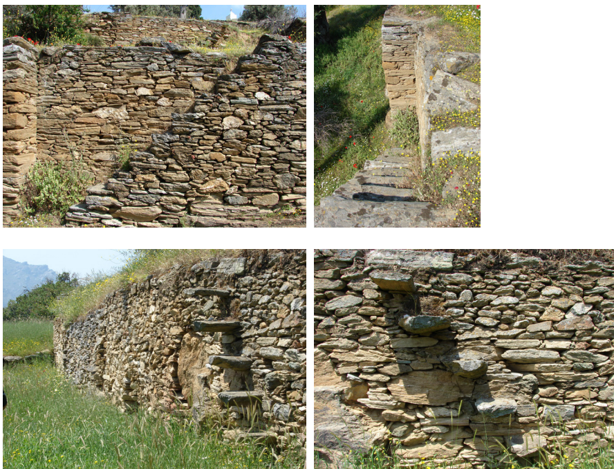
Figura 15 - Scale realizzate per risalire i terrazzamenti. Possono essere costituite da gradini pieni, ricavati sagomando lo spessore del muro (in alto), oppure da lastre di pietra a sbalzo (in basso).
