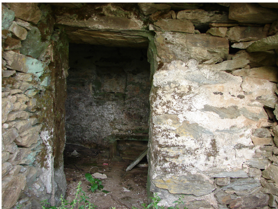
Figura 3.8 - In alto, dettaglio di una delle aperture di accesso; in basso, veduta dell'interno.
