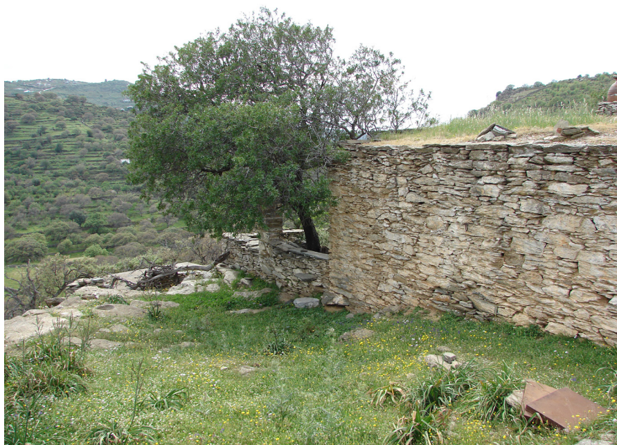
Figura 3.1 - In alto, dettaglio dei gradini di ingresso alla proprietà ricavati tra il muro di terrazzamento e la facciata posteriore. In basso: vista del fronte sud-orientale; si nota l'accostamento tra il muro della cellula e il muro dello stegadi.
