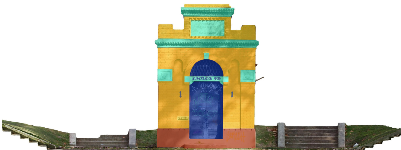
Fig. 8: Scomposizione semantica sulla Subestación situada su Avenida de los Italianos al fine di rintracciare elementi ripetibili in tutti gli edifici della società elettrica.
