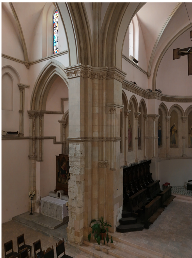
Fig. 8: Cosenza, cattedrale di Santa Maria Assunta, veduta verso il semipilastro sinistro della crociera (foto dell'autore).
