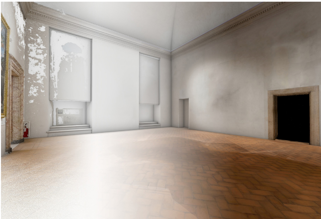
Fig. 7: La nuvola di punti acquisita attraverso il rilievo fotogrammetrico.
