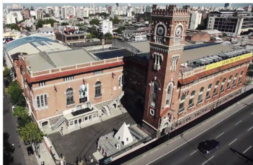
Usina Pedro de Mendoza (Caso studio) – Barrio La Boca
