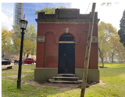
Subestaciones 22 – Av. De Los Italianos
