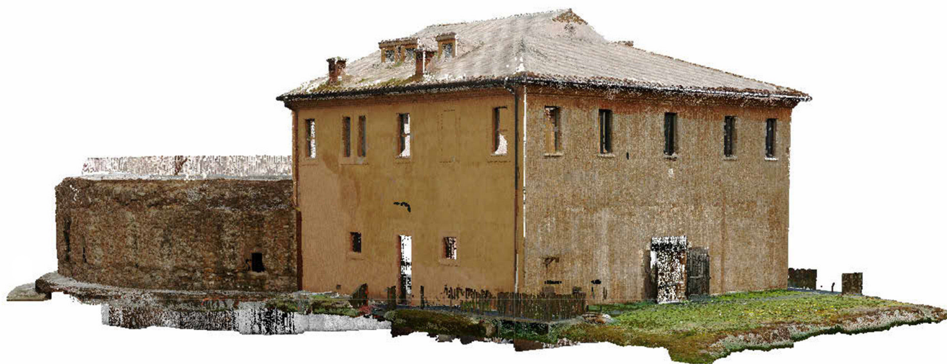
Fig. 2: Nuvola di punti ottenuta da laser scanner 3D.
