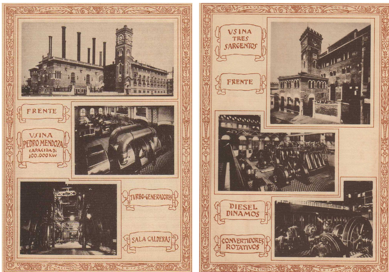
Fig. 3: Locandine per l'inaugurazione della Compañía Ítalo Argentina de Electricidad che inquadrano la Usina principale in via Pedro de Mendoza. 1916. Fonte: Buenos Aires, Talleres gráficos de la Cía. General de Fósforos.
