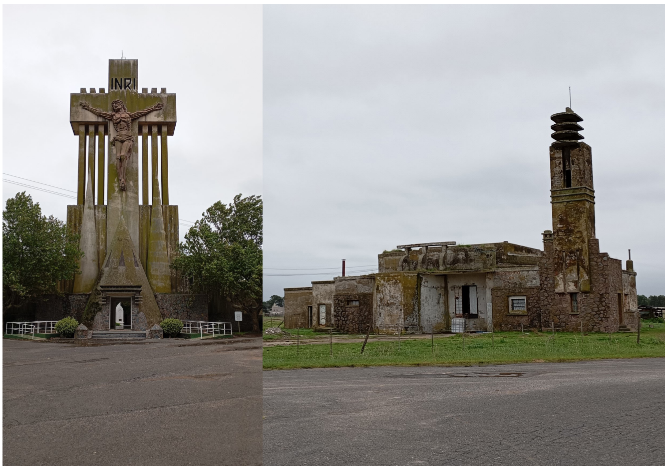
Fig. 3: Matadero y Portal del Cementerio de Laprida. Imágenes de los autores.
